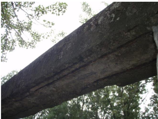
odpadlý beton na spodní straně žlb.madla zábradlí
