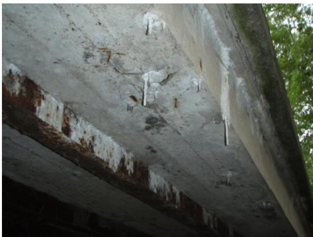
vápenité inkrustace a krápníky na boku a podhledu NK zprava
