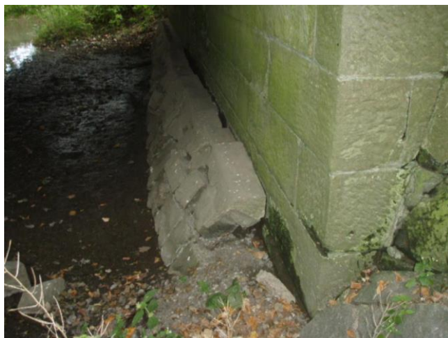
odtržené a částečně rozpadlé kamenné zpevnění opěry na konci mostu
