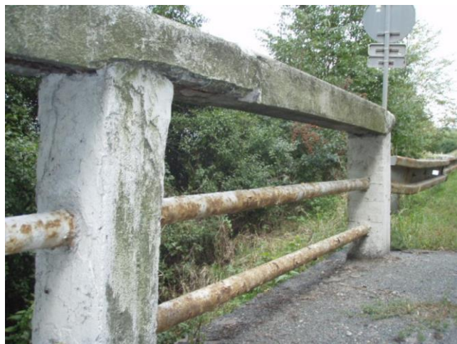
koroze ocelové výplně zábradlí
