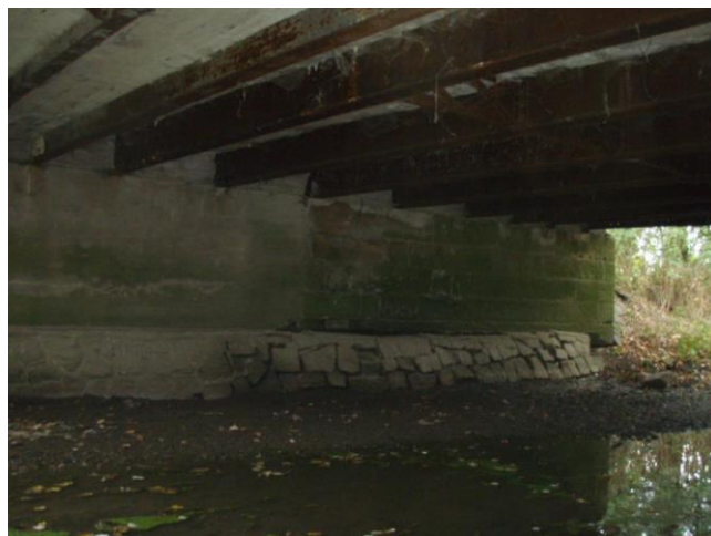
koroze ocelových nosníků v podhledu NK
