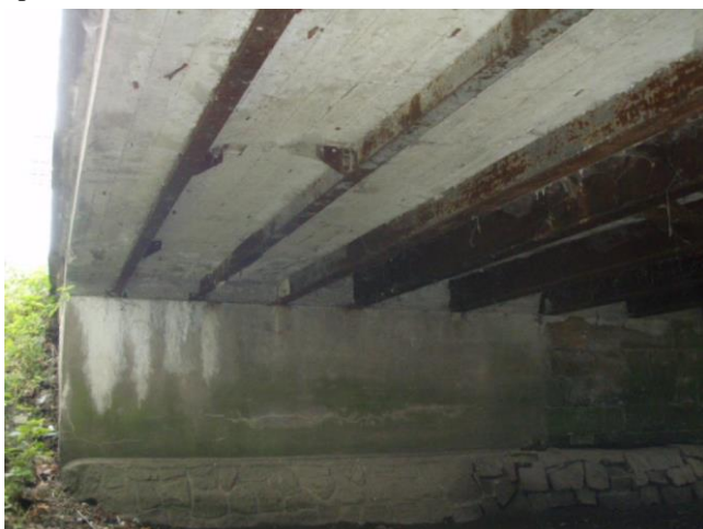
vápenité výluhy na čele opěry na konci mostu vlevo
