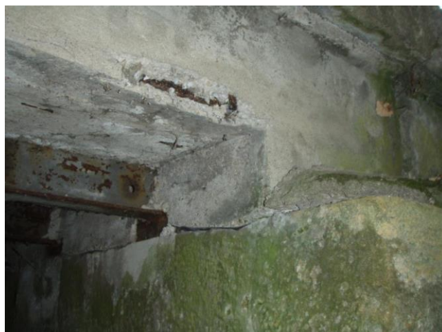
odpadlý beton na hraně NK vpravo s obnaženou výztuží
